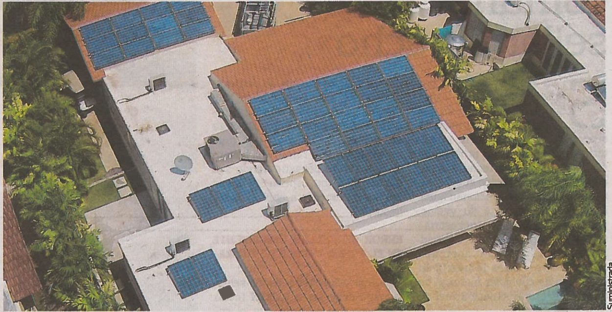
Los paneles solares son resistentes a huracanes de hasta 130 mph y su mantenimiento es mínimo.
